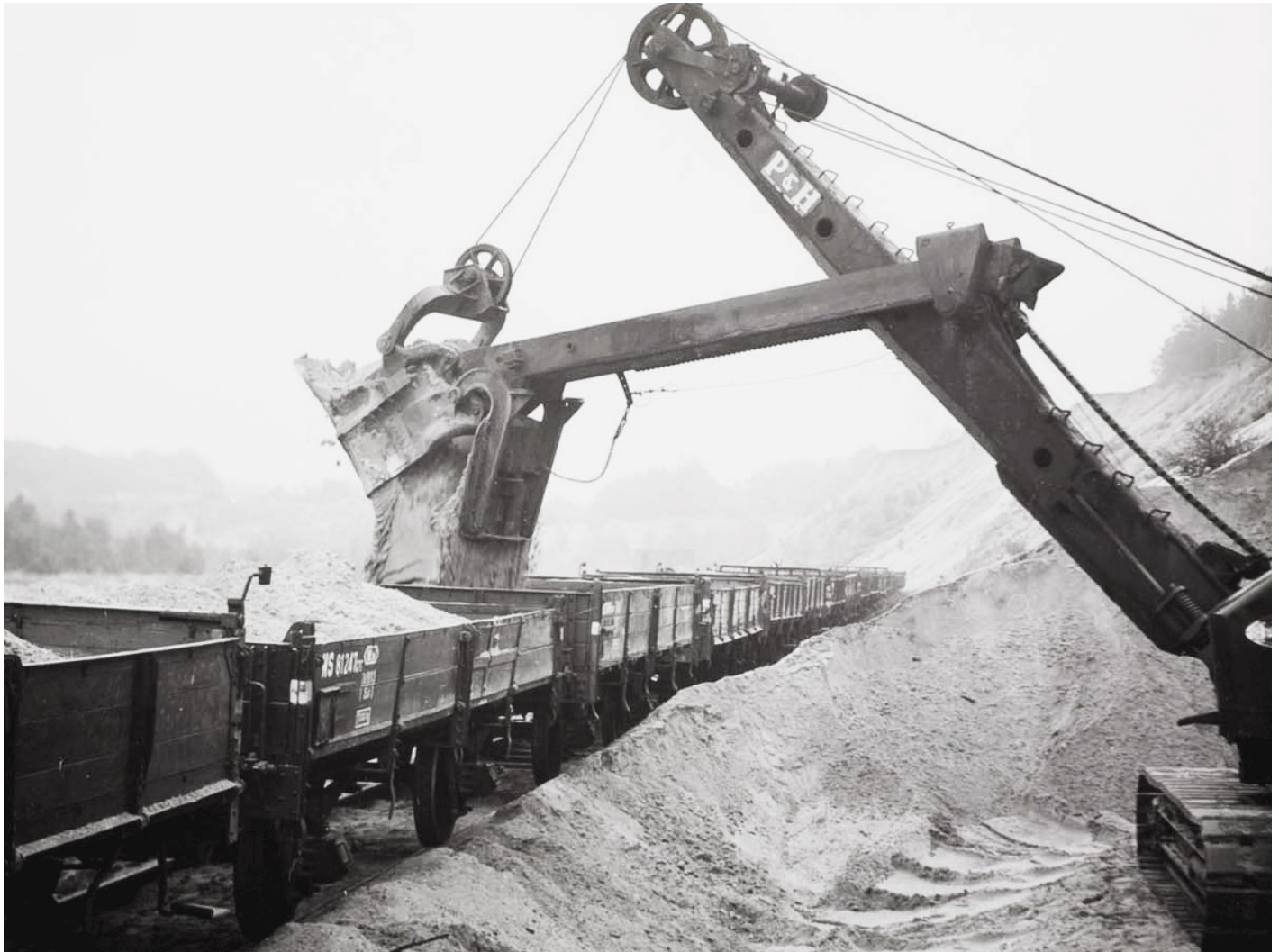
Voormalig HSM zandwagen NS 81247 wordt met een grijper gevuld met zand
