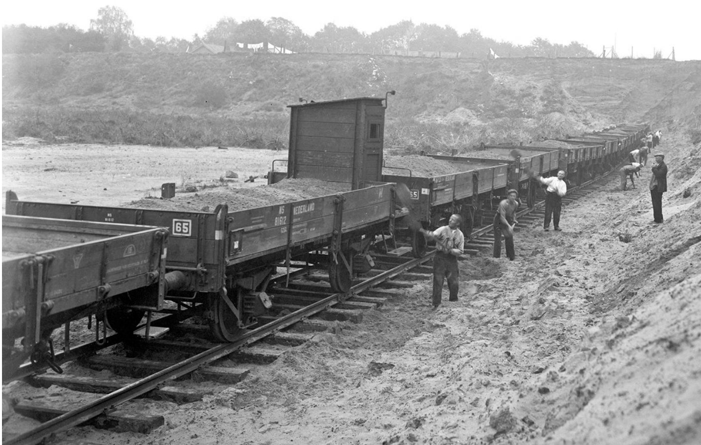
Goed in beeld staat hier zandwagen NS GZG 81612 welke met 't handje wordt volgeschept. De wagen is inmiddels voorzien van NS W1 aspotten en heeft ook geen hoog kopschot meer.
