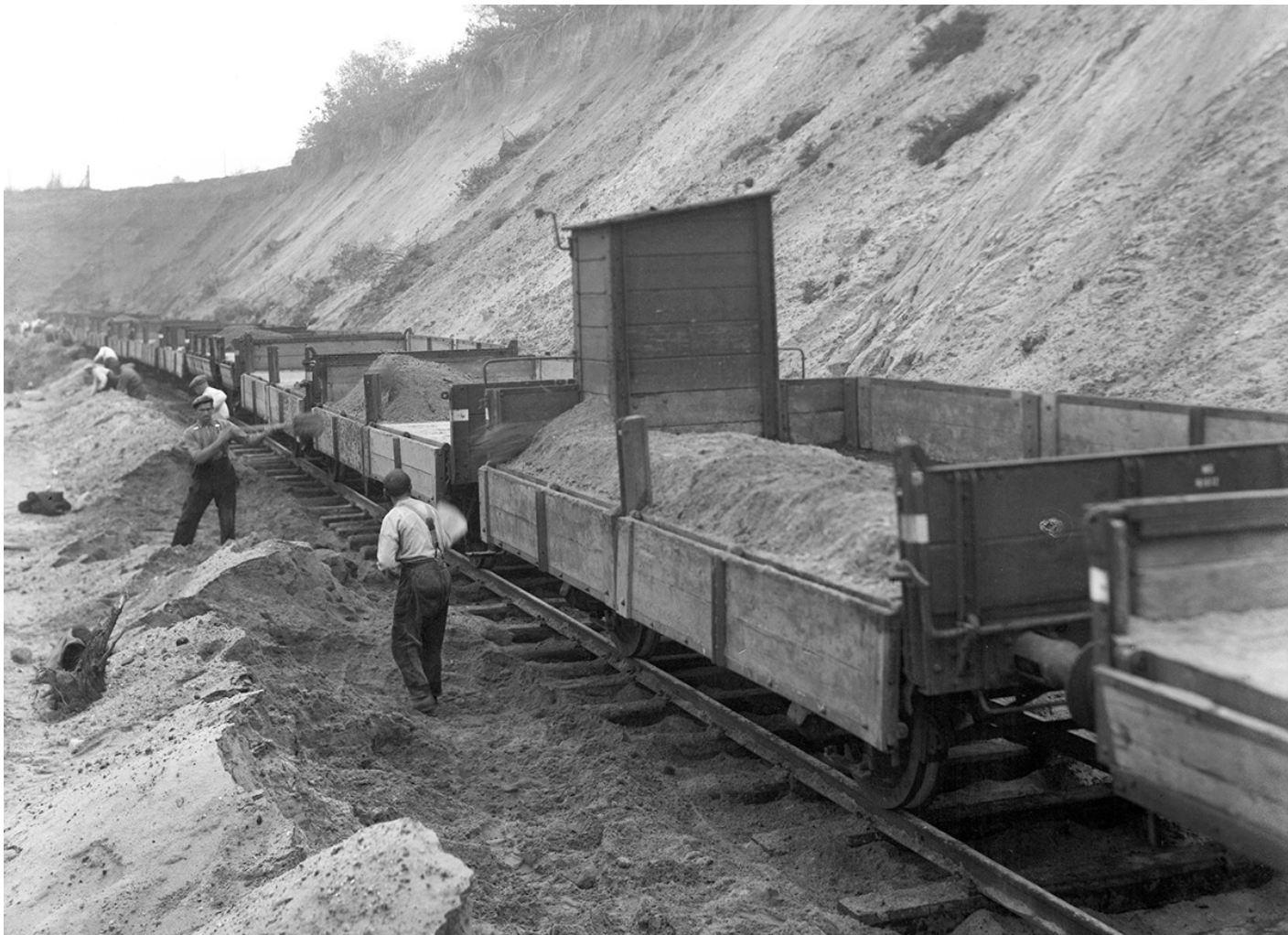
Bij deze HSM-zandwagens zien we dat het remhuis door zand omgeven is.
